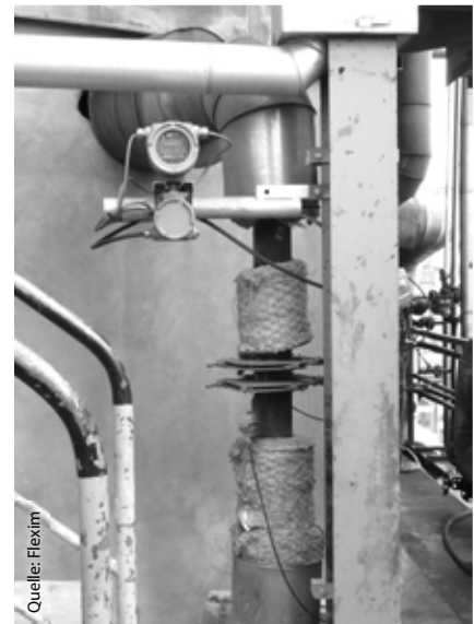
Abb. 1: Die Messstelle der Overflash-Mengenmessung mit dem Messumformer Fluxus (oben) und der Sensoranbringungs Vorrichtung WaveInjector (unten).
