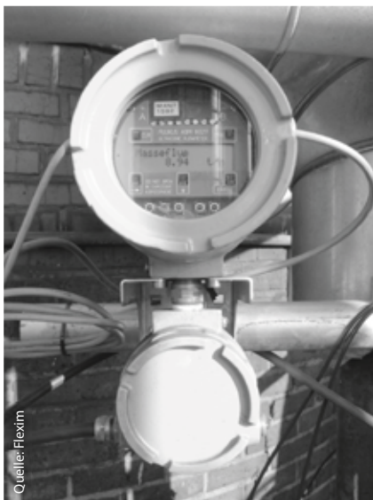
Abb. 2: Zuverlässig erfasst der explosionsgeschützte Messumformer Fluxus ADM 8027 den Massefluss der Overflashmenge.
